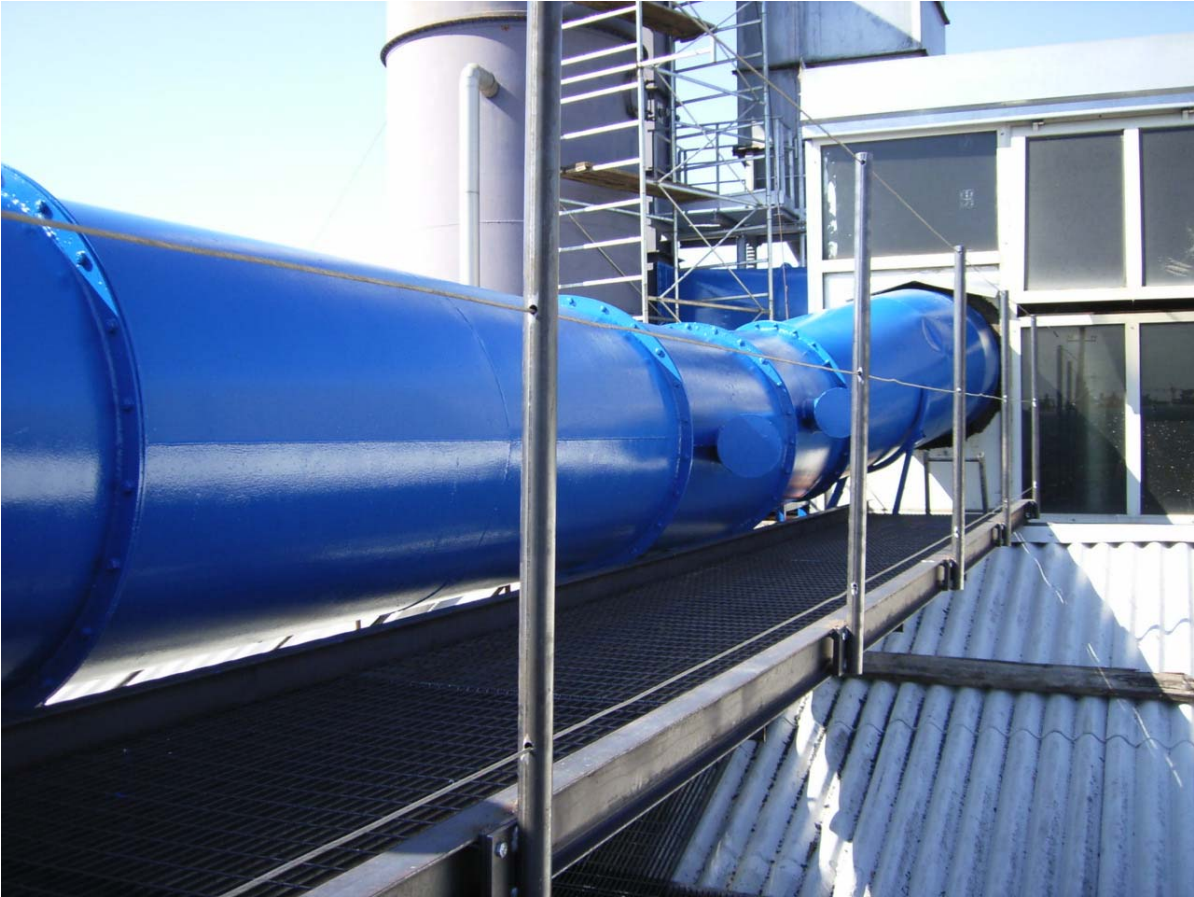
Tubazione aspirazione aria
